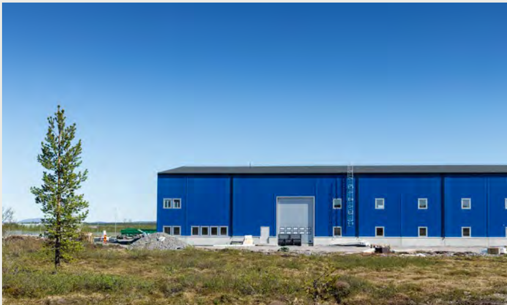
Den nybyggda fastigheten i Kiruna. Byggnaden blir färdigställd under sommaren 2017.
